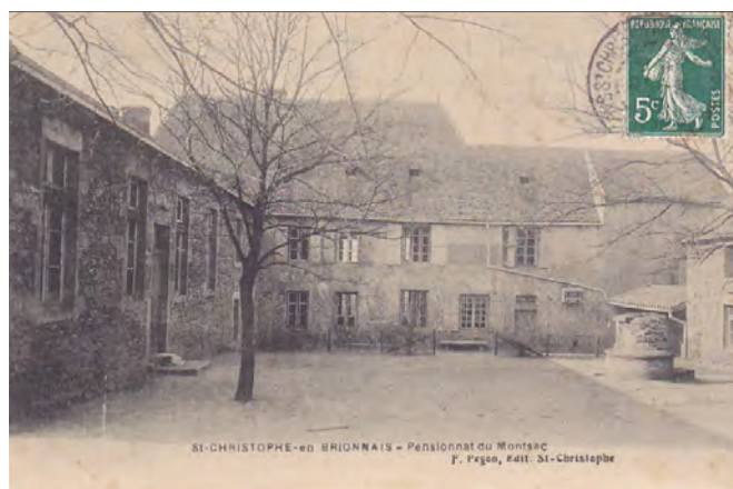
Au fond de la cour centrale, la partie la plus ancienne du bâtiment du Montsac (© Carte postale ancienne, collection privée)
