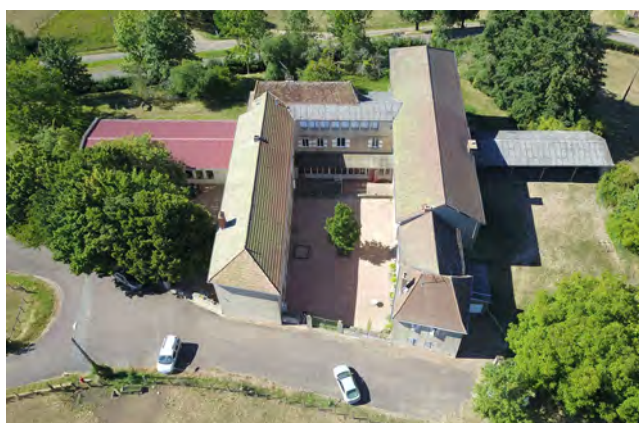
Vue générale du bâtiment prise par un drone (août 2020, © CEP)
